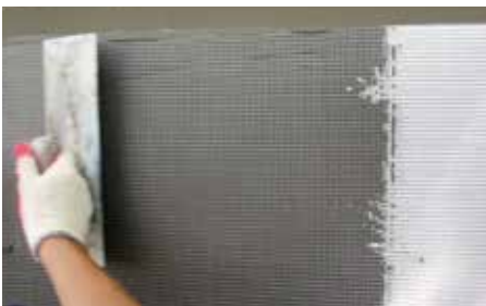
4. 메쉬 미장 시공
