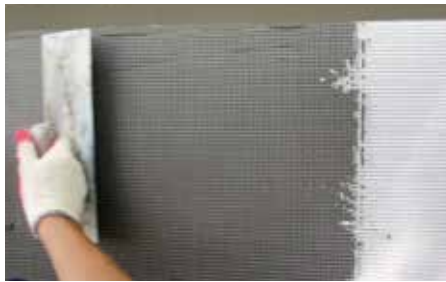
4. 메쉬 미장 시공
