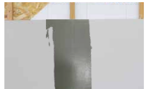
3. 조인트 메쉬 시공
