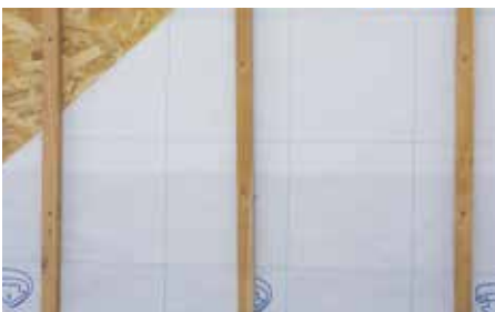
1. OSB 합판 위 방습지 시공 및 나무상 설치
