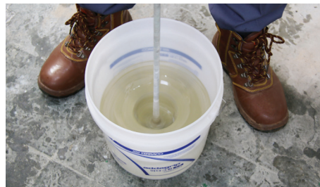
2. Mix resin with hardener 수지와 경화제를 혼합합니다.
