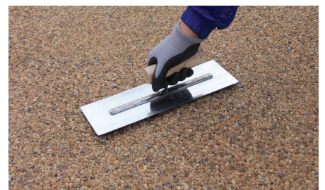
5,6. Compact material by trowel 흙손 작업으로 최종 마무리합니다.
