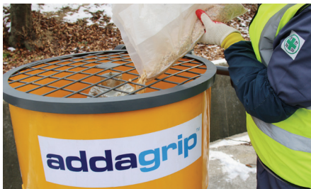
1. Charge the Mixer with aggregate 믹서에 영국식 정원석을 투입합니다.
