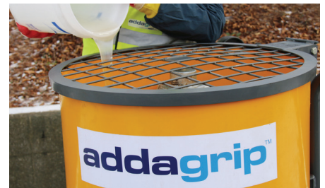
3. Add mixed resin to mixer 혼합한 수지를 믹서에 투입합니다.
