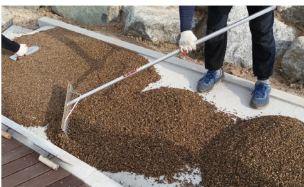
4. Spread material on surface 혼합된 제품을 고르게 펼칩니다.
